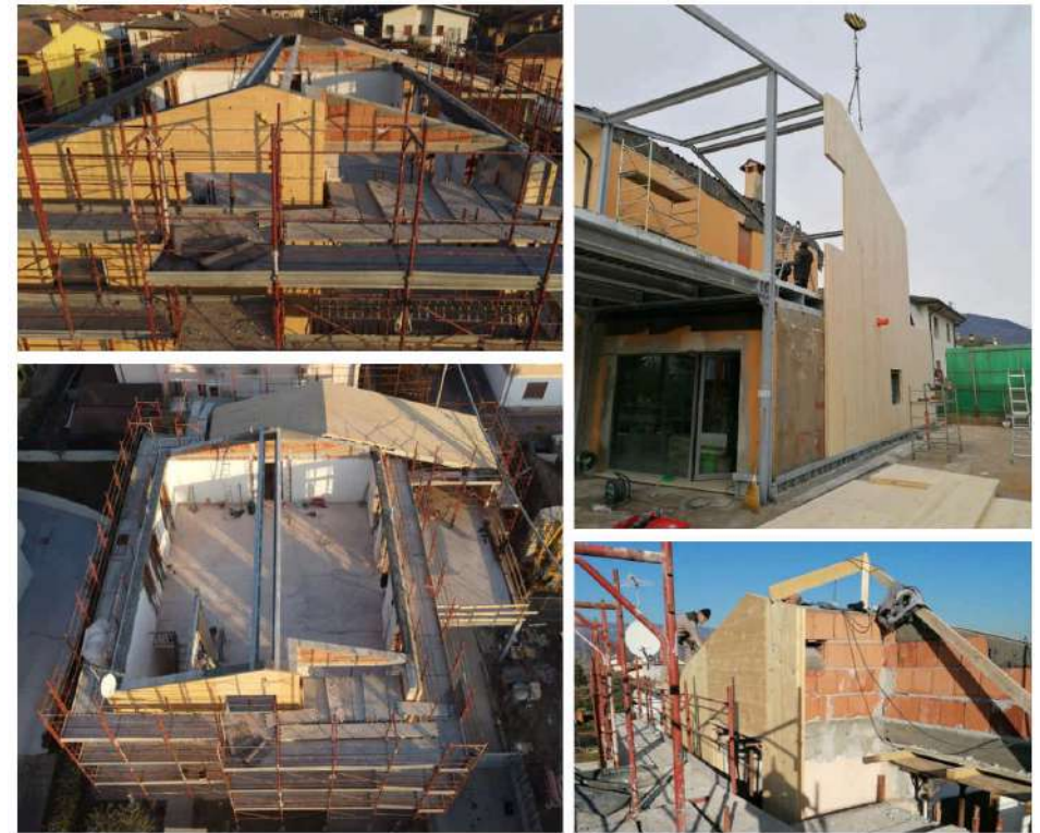
Figura 14 - Immagini dell'intervento in fase di realizzazione (cortesia di Ing. Artuso)
