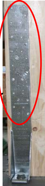
Hold-down con 12 chiodi \phi 4 \times 60 mm
