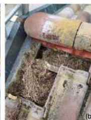
Situazioni di degrado in dettagli costruttivi relativi a: a) nodo copertura; b) nodo copertura; c) nodo balcone-parete
