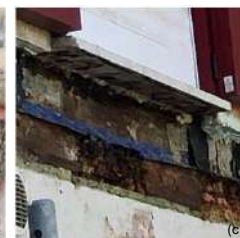
Situazioni di degrado in dettagli costruttivi relativi a: a) nodo copertura; b) nodo copertura; c) nodo balcone-parete
