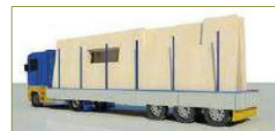
Rinforzo applicato ai soli maschi, pannelli continui (RP2)
