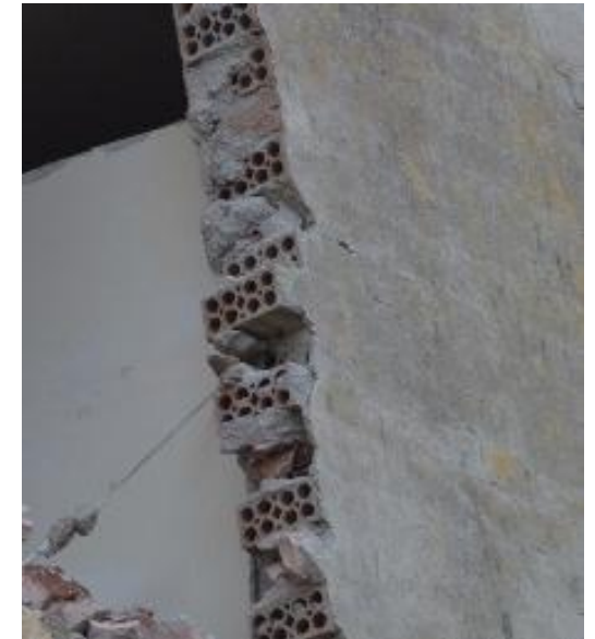
Blocchi forati (scala interna)
