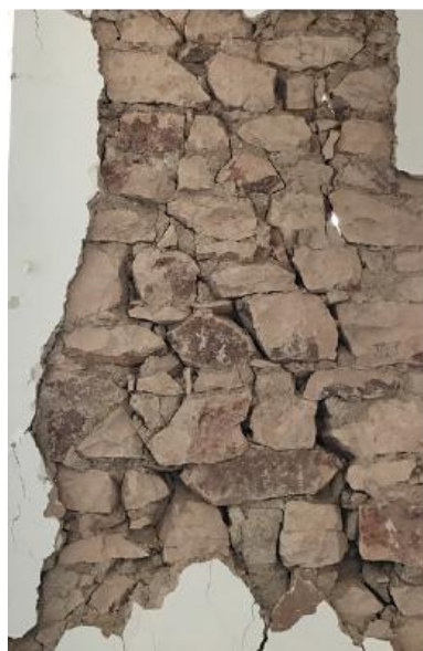
Muratura a conci sbozzati, con paramenti di spessore disomogeneo
