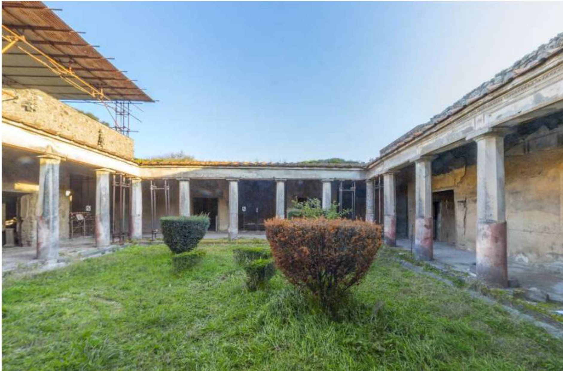
Vista del peristilio rodio: lato sud/est
