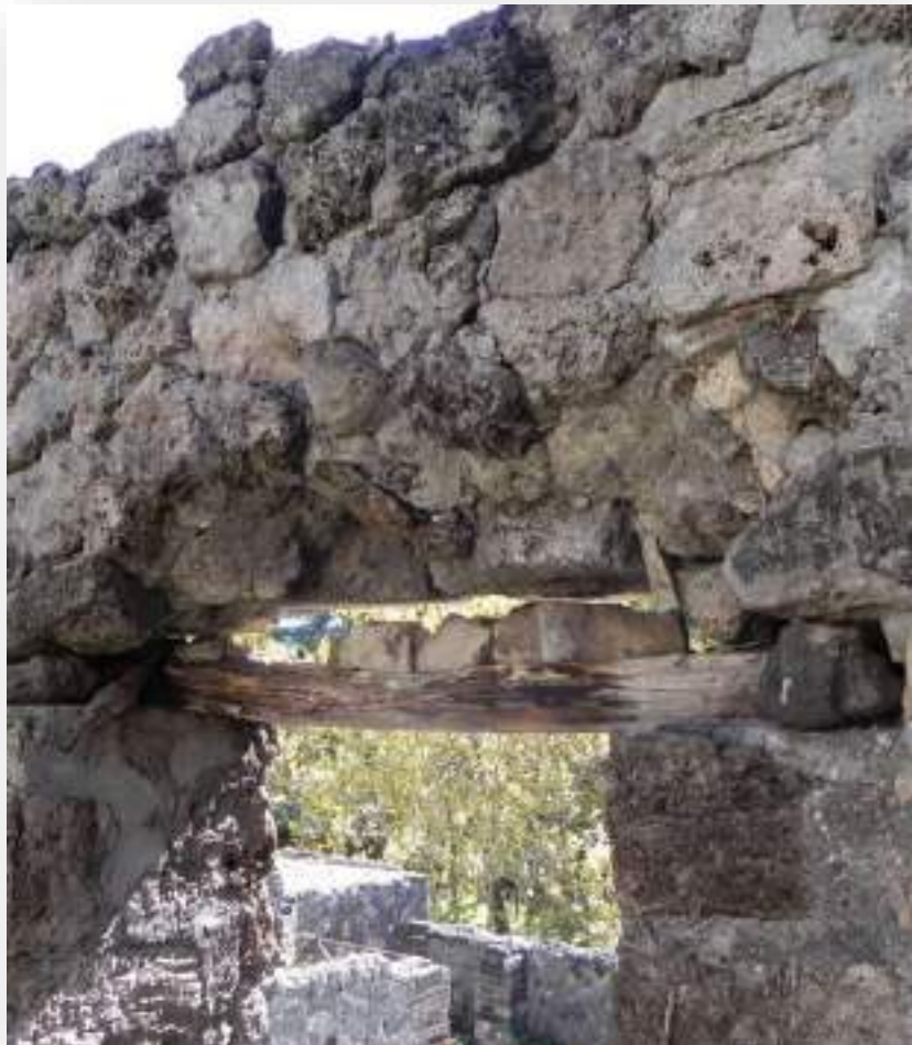
architravi degradati
