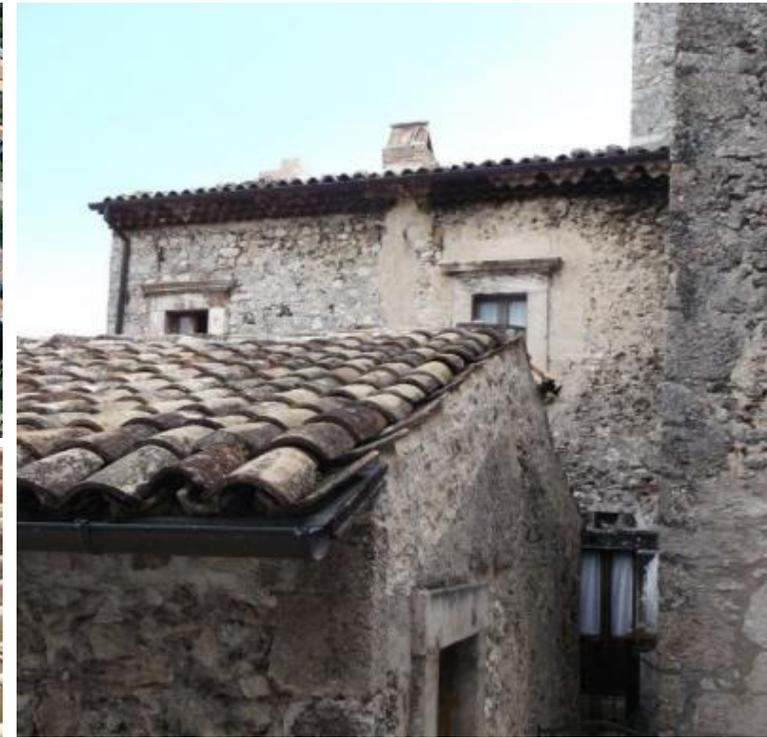
Recupero del manto di copertura originale con reintegrazione con coppi di recupero o realizzati a mano.
