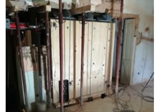
Miglioramento sismico ed efficientamento energetico con pannelli CLT e OSB
