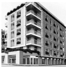
EDIFICI IN C.A.
