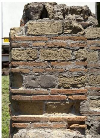
Il **degrado per erosione** dei giunti e alveolizzazione, scagliatura e polverizzazione del blocco inducono **riduzione della superficie resistente** e un **peggioramento della diffusione dei carichi**, con possibile innesco di **eccentricità dei carichi**. L'assenza, o carenza, di manutenzione accelera i fenomeni.
