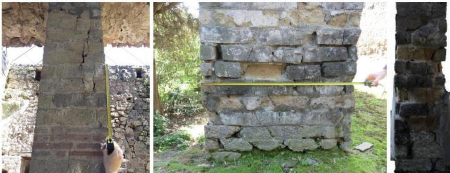
**Lesioni verticali da schiacciamento** concentrate soprattutto nella parte di pietra di tufo che risulta essere più degradata e in pessimo stato di conservazione. Lo schiacciamento dei pilastri comporta spesso l'espulsione di materiale nella base del pilastro, con conseguente riduzione della sezione, soprattutto in corrispondenza degli spigoli, luogo in cui si concentrano le tensioni
